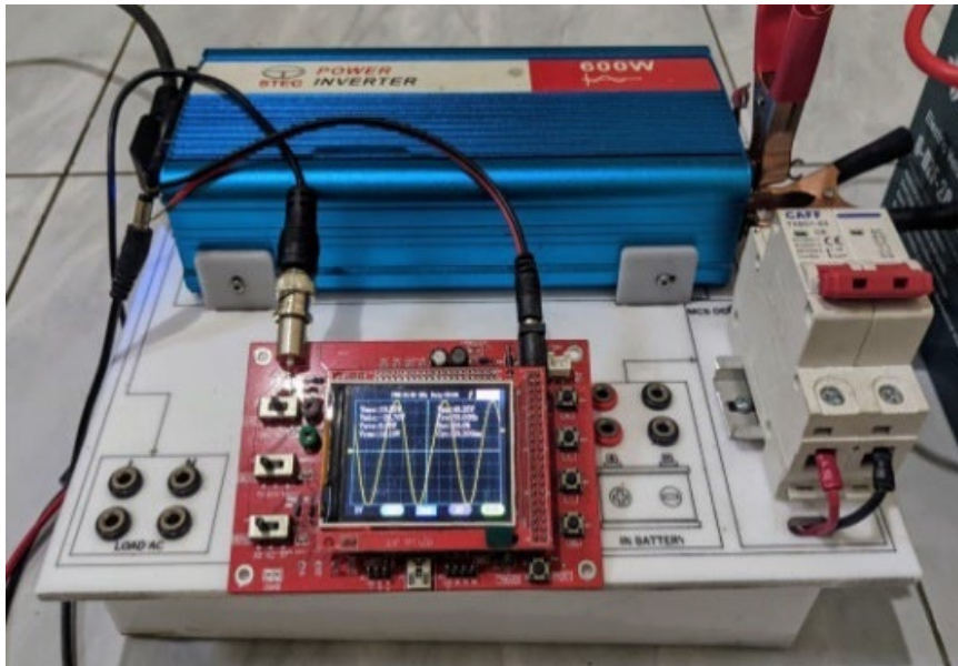
Gambar 2. Pengujian Inverter Sistem PLTB
