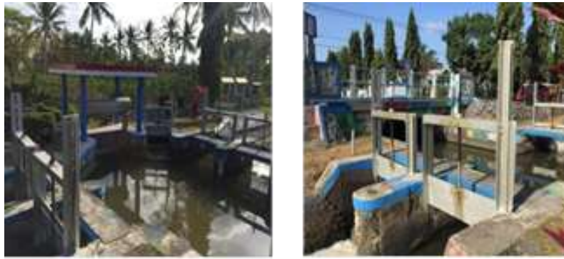
Gambar 1. Dam Limo dan Pintu Air Barat
