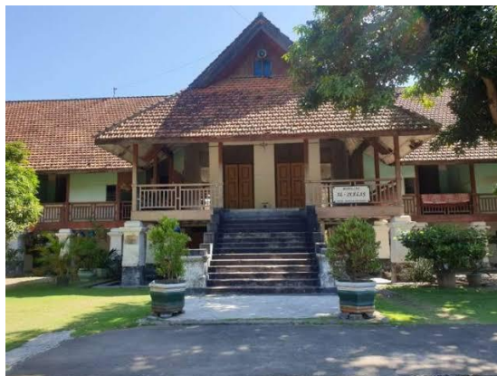
Gambar 2. Kondisi Bangunan Inggris yang masih baik (Sumber : Data Pribadi, 2024)
