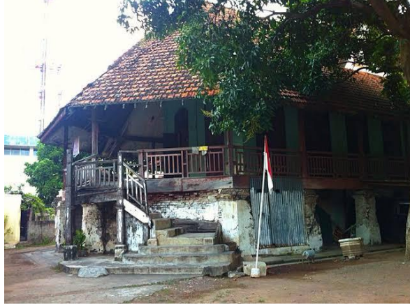
Gambar 1. Kondisi Bangunan Inggris yang sudah rusak (Sumber : Data Pribadi, 2024)
